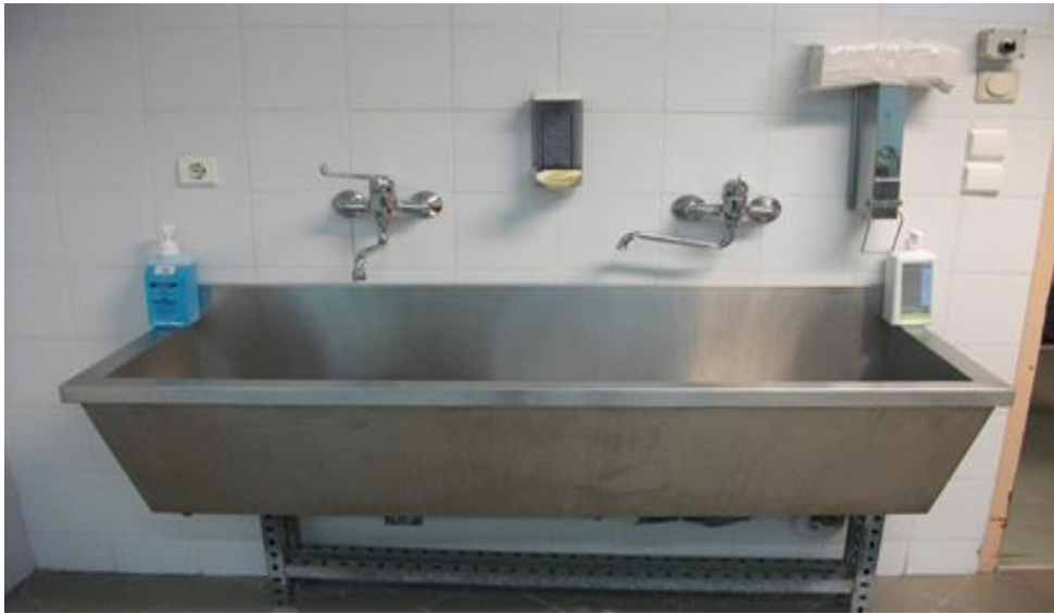
Εικόνα 4. Δεξαμενή (detergent pool) πλύσης και απολύμανσης υποδημάτων
