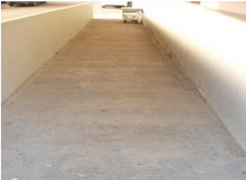
Εικόνα 17. Κεκλιμένος διάδρομος διαφυγής
