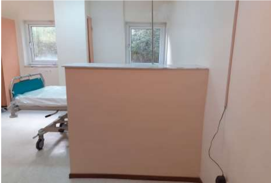
Εικόνα 2. Θωρακισμένος θάλαμος με μολύβι για νοσηλεία ασθενών με I 131.
