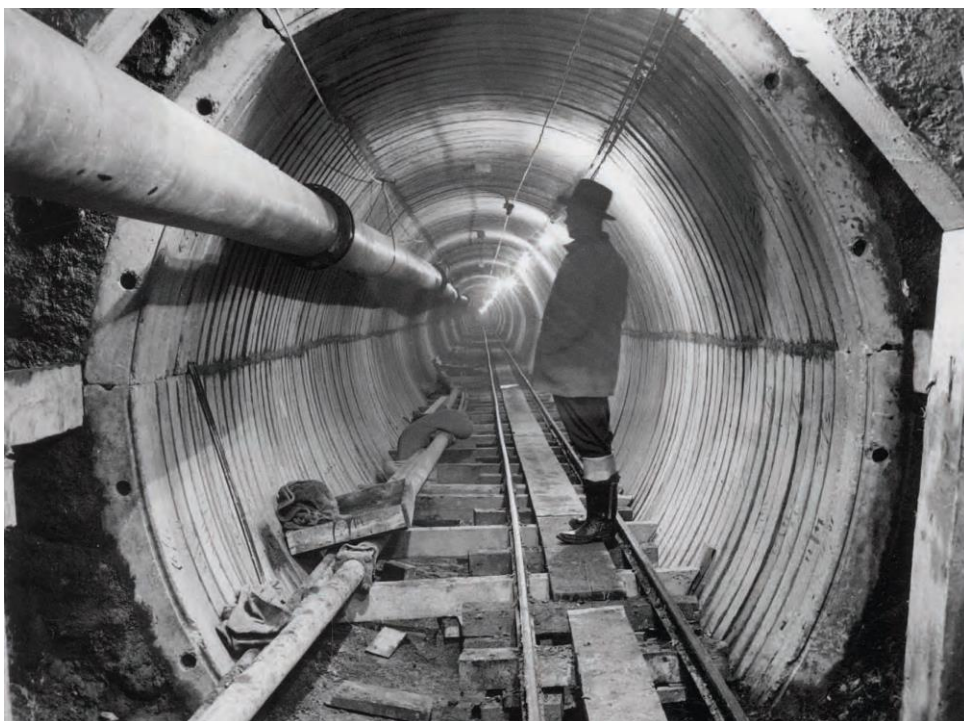
Κατασκευή σήραγγας Μπογιατίου (1929).
