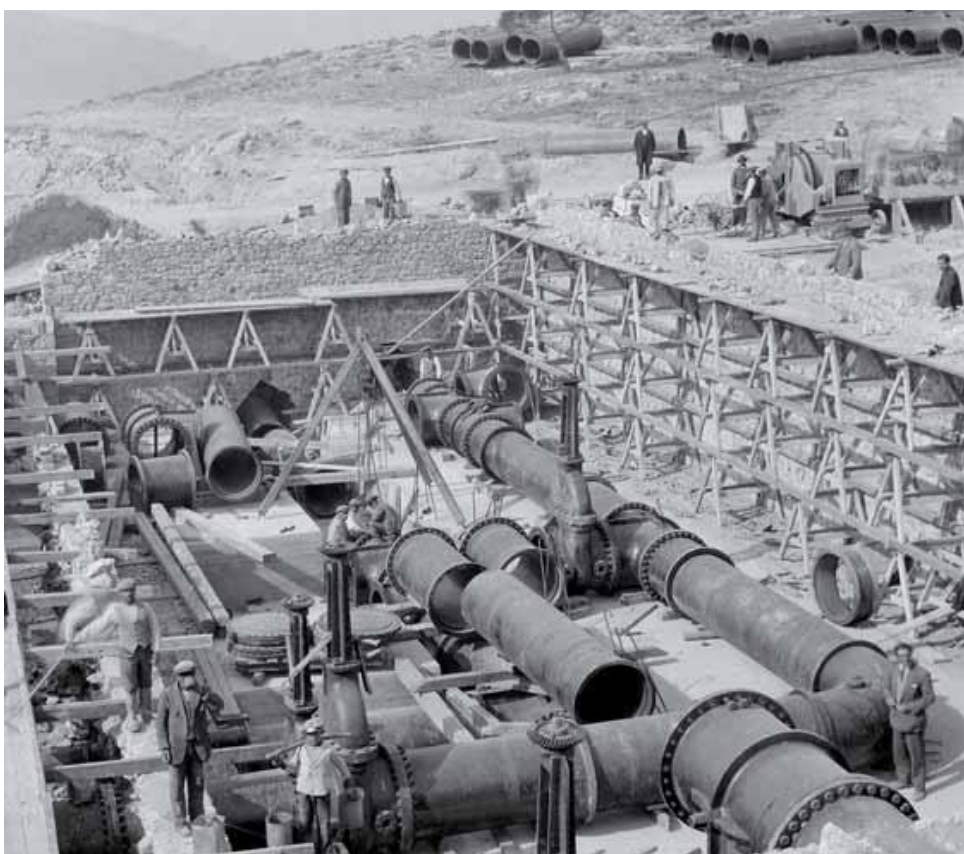
Κατασκευή διυλιστηρίου Γαλατσίου. (1927).
