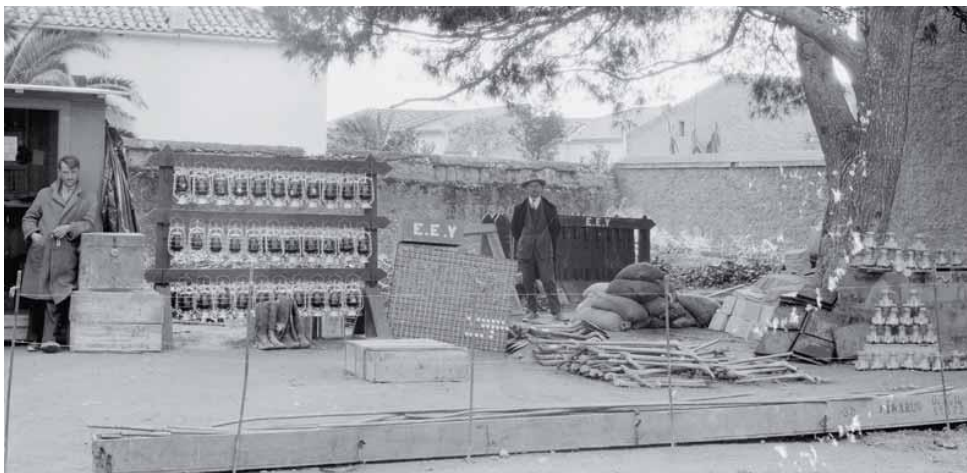
Εργοτάξιο έργων ύδρευσης. (1935).
