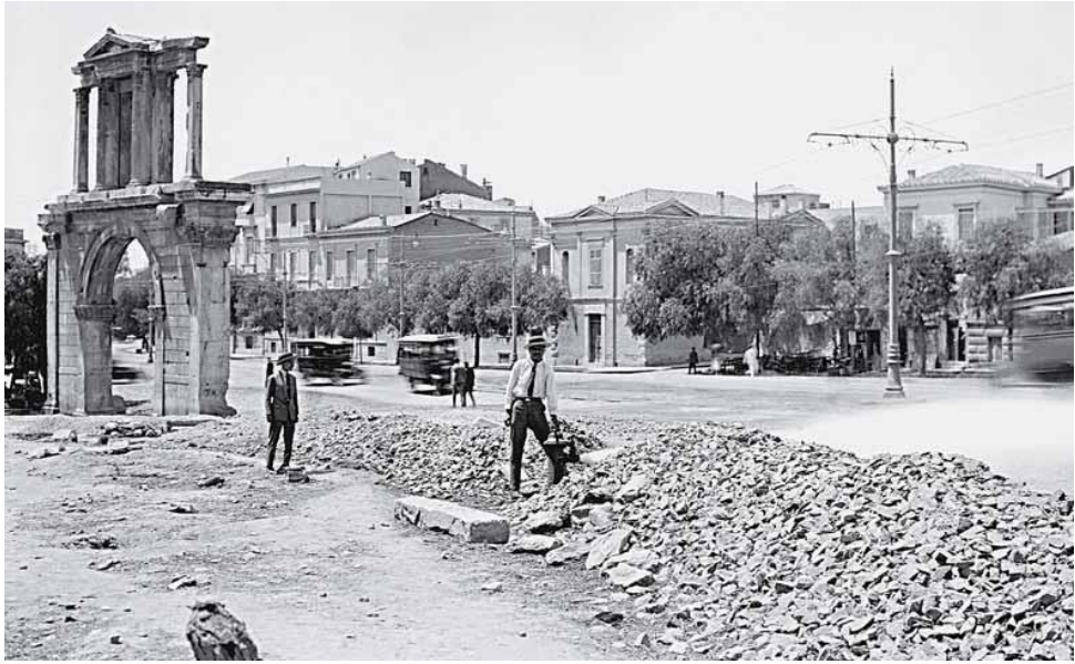
Τοποθέτηση αγωγού εντός του αστικού ιστού. (1932).
