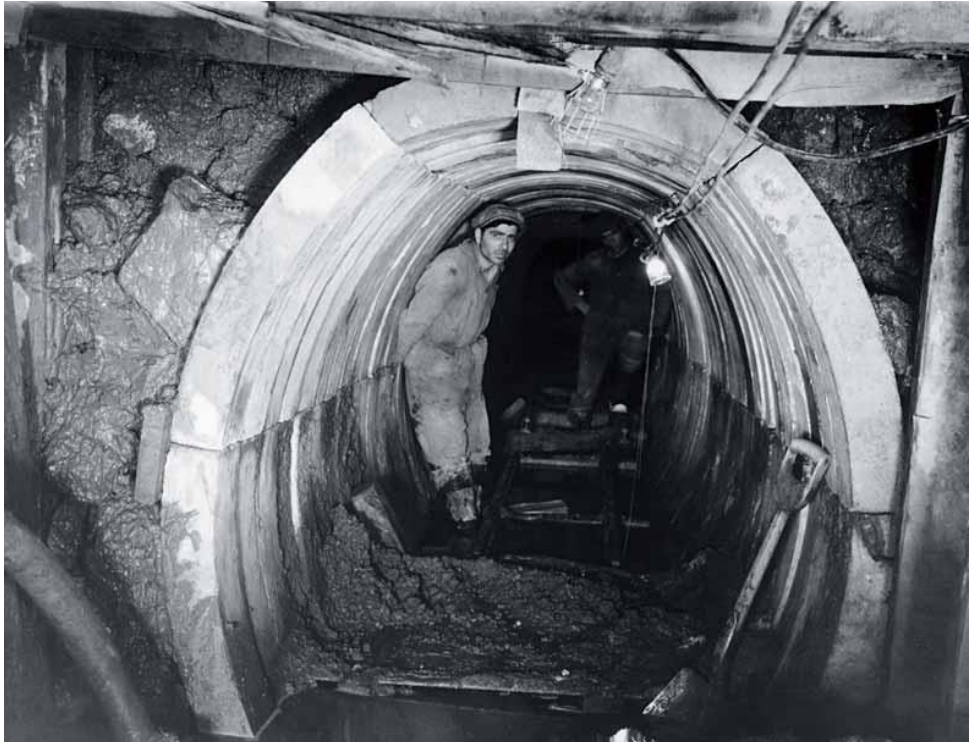
Κατασκευή σήραγγας Μπογιατίου. (1927).
