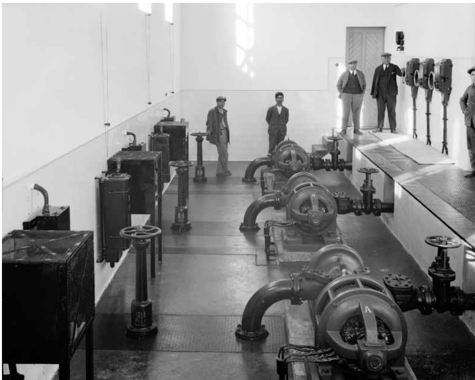
Αντλιοστάσιο διυλιστηρίου Γαλασίου. (1930).
