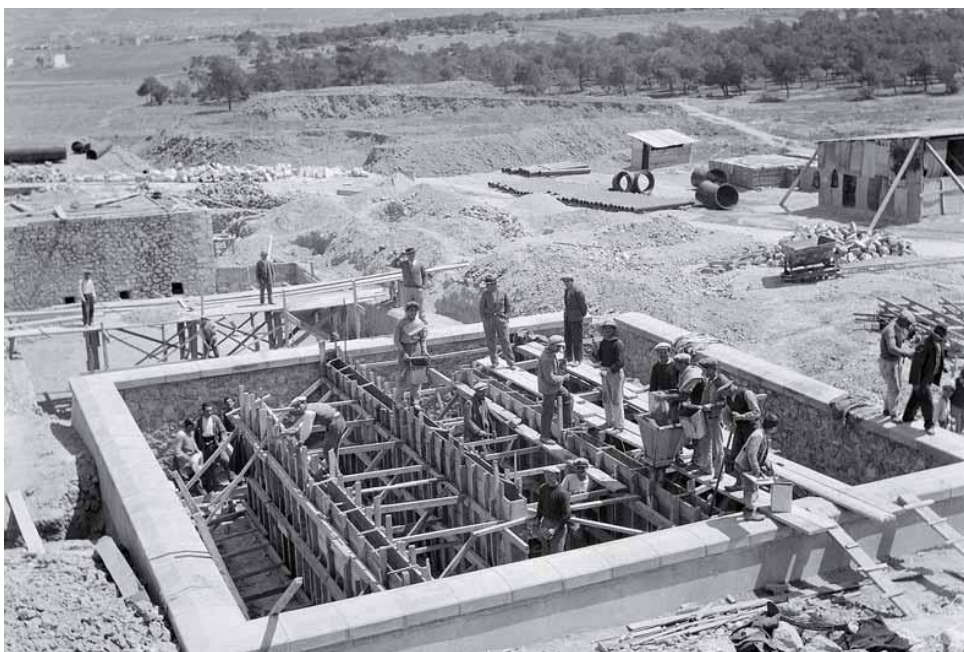
Κατασκευή διυλιστηρίου Γαλατσίου. (1927).
