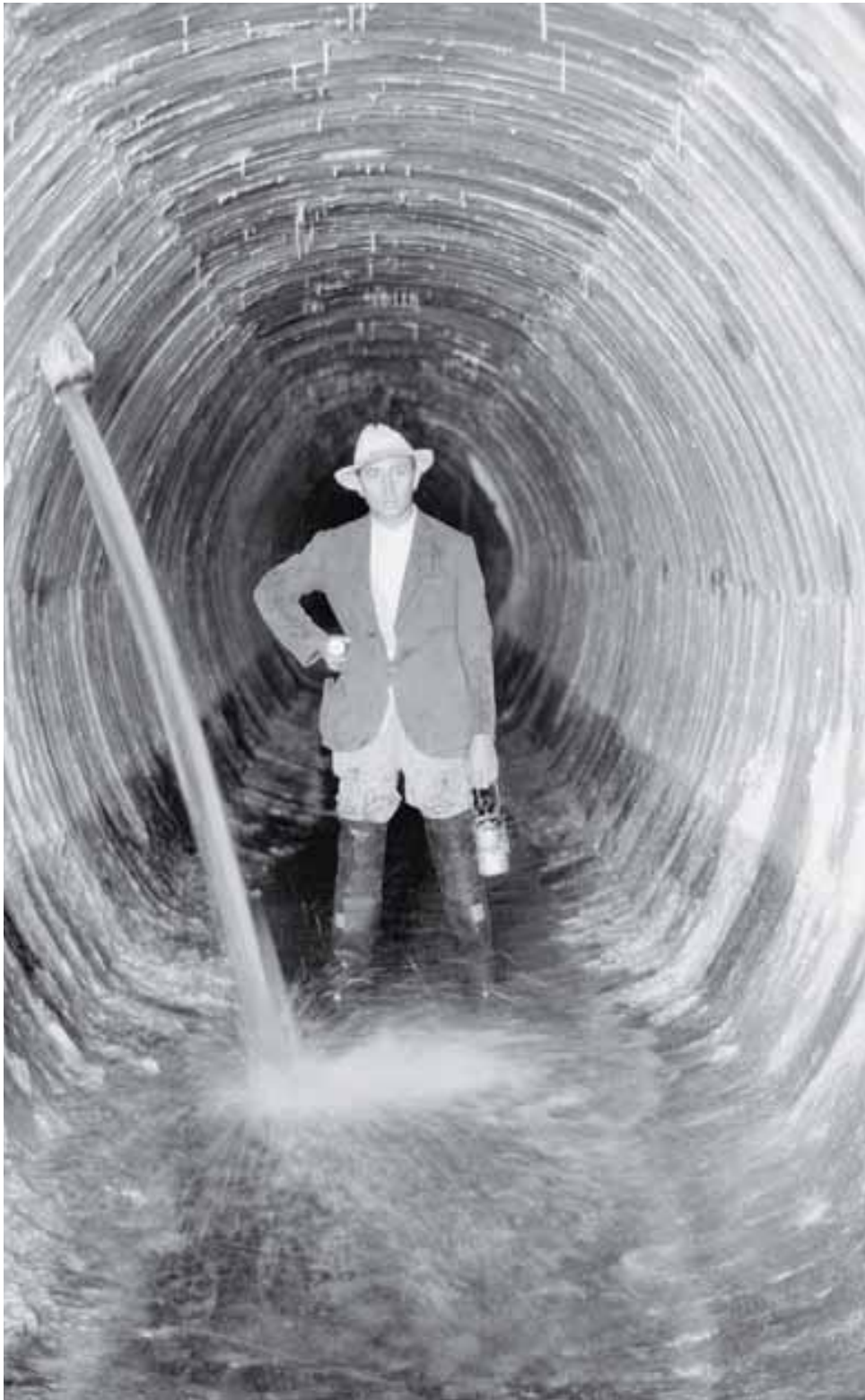
Κατασκευή σήραγγας Μπογιατίου. (1928).
