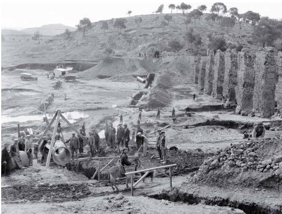
Τοποθέτηση αγωγού στο Αδριάνειο υδραγωγείο. (1929).
