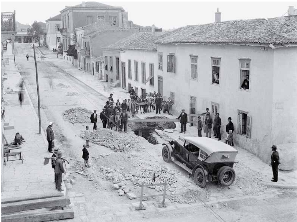
Επισκευή αγωγού εντός πόλεως. (1930).
