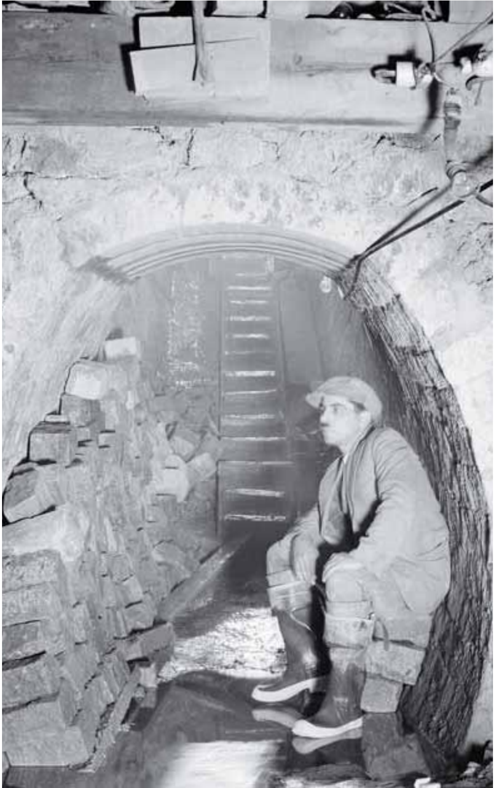
Κατασκευή σήραγγας Μπογιατίου. (1928).
