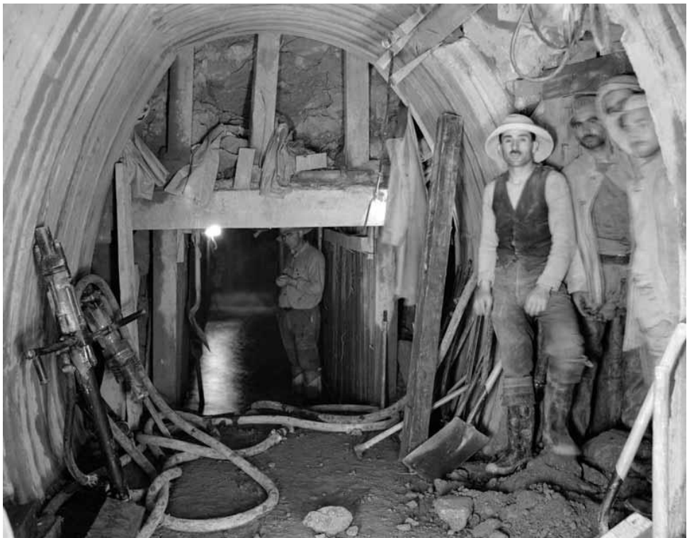
Κατασκευή σήραγγας Μπογιατίου. (1927).
