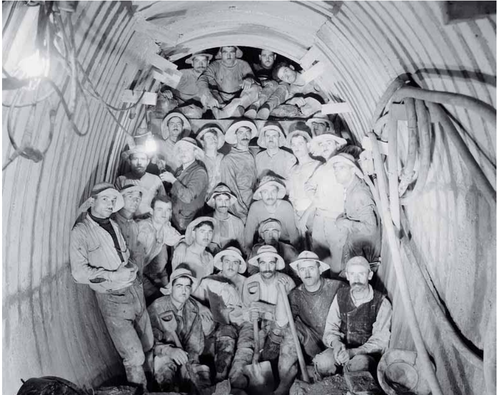
Κατασκευή σήραγγας Μπογιατίου. (1928).
