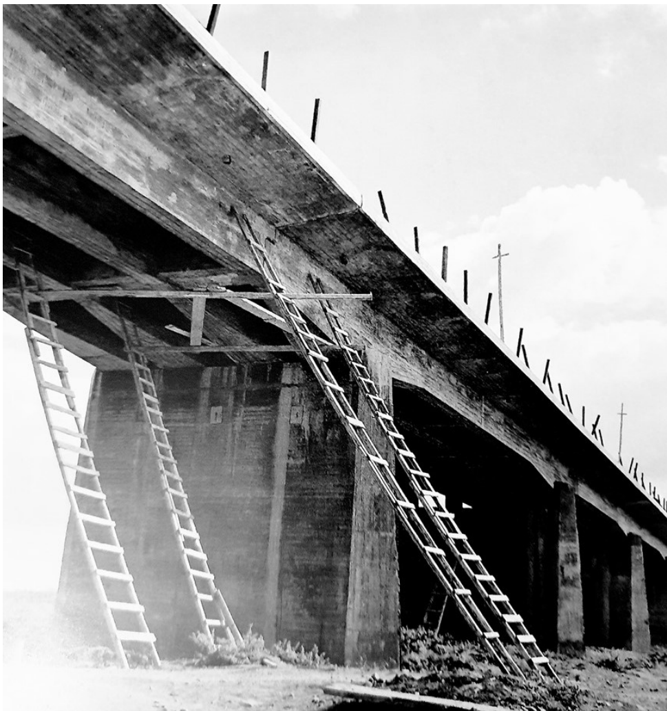
Εικόνα 1. Σκαλωσιές κατά την κατασκευή της Γέφυρας των Κήπων.
