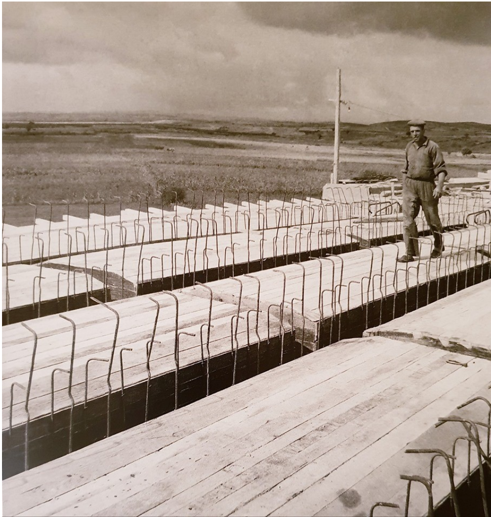
Εικόνα 2. Εργάτης κατά την κατασκευή του ξυλότυπου της Γέφυρας των Κήπων.
