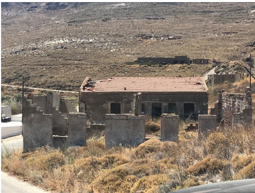
Εικόνα 16. Κτίριο φιλοξενίας των μεταλλωρύχων στα μεταλλεία της Σερίφου. Ο όρος που χρησιμοποιούσαν οι μεταλλωρύχοι ήταν «κελλιά».
