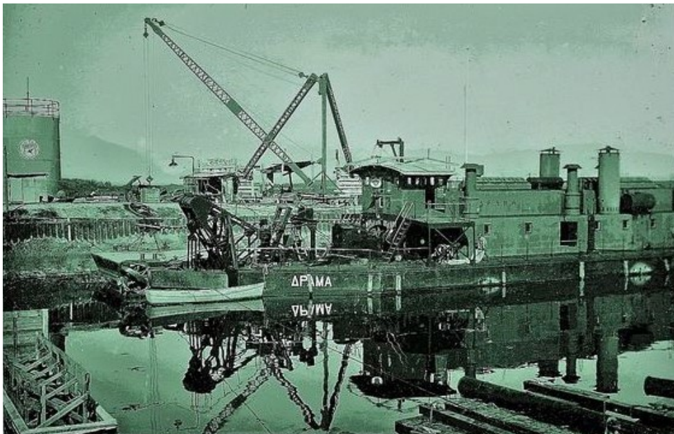
Εικόνα 11. Το πολυδύναμο πλοίο - βορβοροφαγάνα, βαπτισμένο «Δράμα» η γνωστή γερμανικής κατασκευής βυθοκόρος στη λίμνη Πρασιάδα σε ώρα εργασίας.
