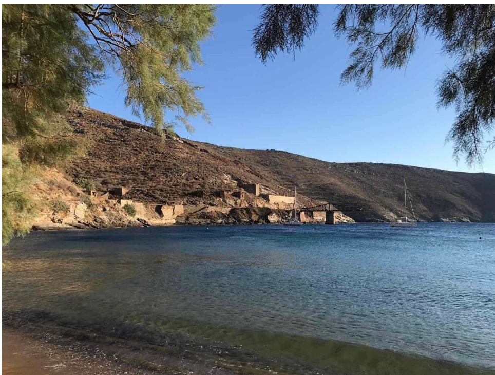
Εικόνα 2. Εγκαταλειμμένες εγκαταστάσεις φόρτωσης των μεταλλείων στη Σέριφο.
