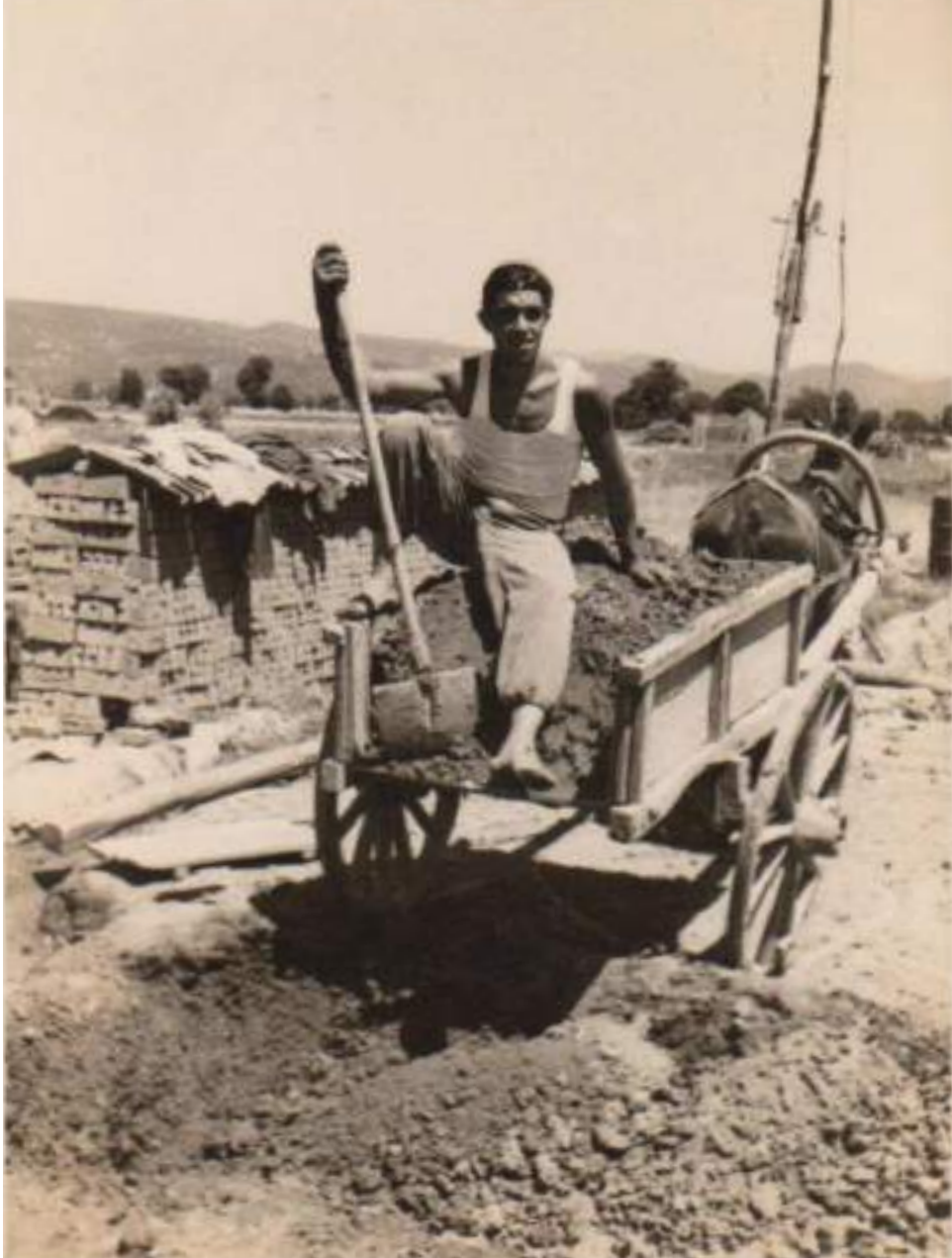
Εικόνα 1. Μεταφορά αργιλώδους πρώτης ύλης για την κατασκευή των τούβλων.
