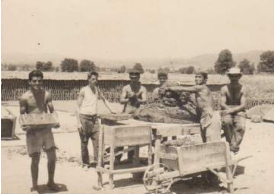
Εικόνα 5. Πάγκος εργασίας για τη μορφοποίηση των τούβλων σε ειδικά καλούπια.
