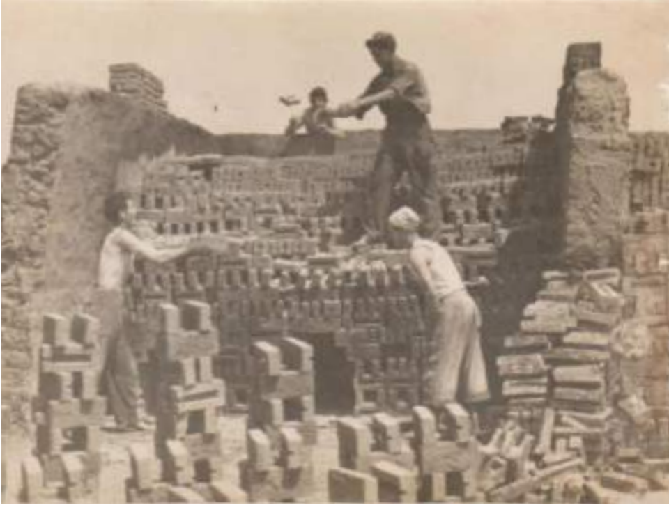
Εικόνα 8. Τοποθέτηση των τούβλων μετά το πρώτο στέγνωμα για το τελικό ψήσιμο.
