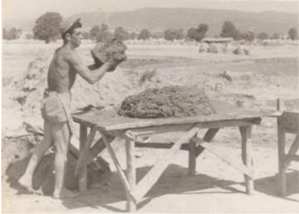
Εικόνα 3. Μεταφορά της ζυμωμένης πρώτης ύλης σε πάγκο εργασίας.
