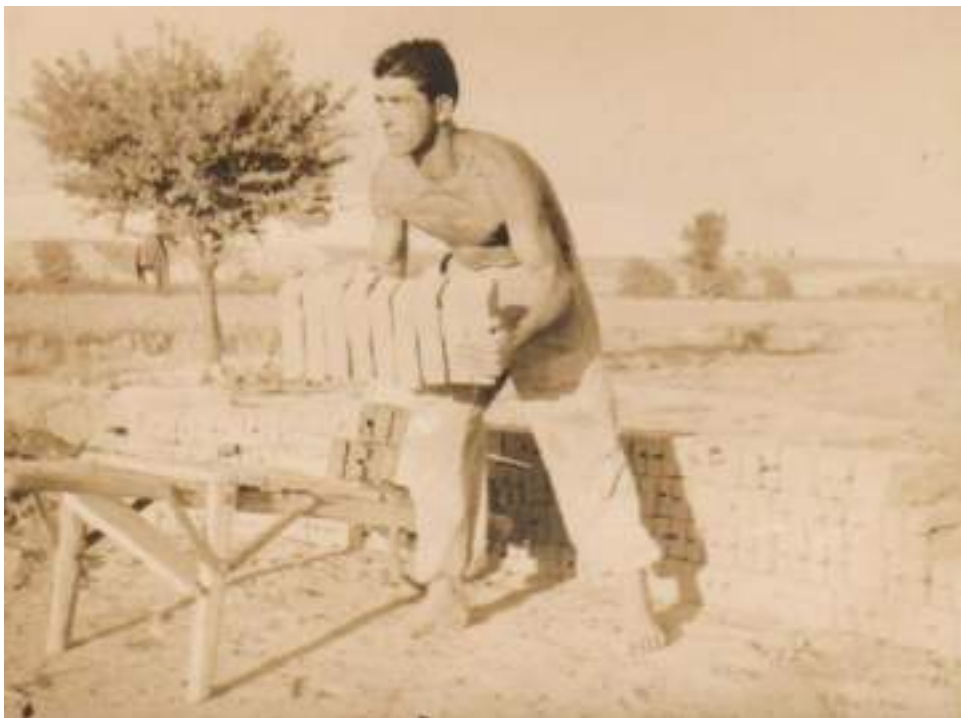
Εικόνα 7. Μεταφορά των τούβλων μετά το πρώτο στέγνωμα.
