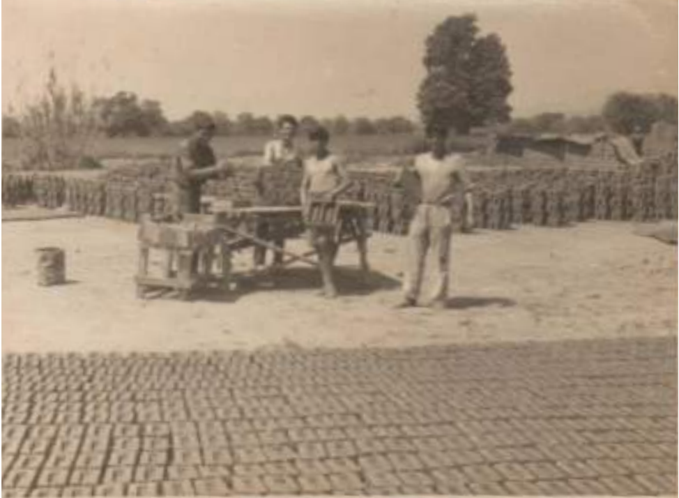
Εικόνα 6. Εύπλαστα τούβλα που μόλις σχηματίστηκαν τοποθετούνται στο έδαφος για το πρώτο στέγνωμα.
