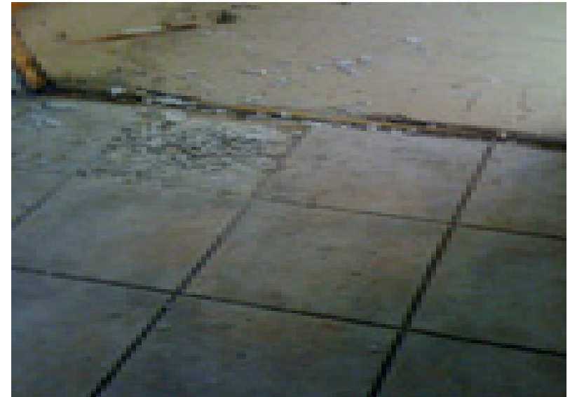
Εικόνα 9. Κεραμικά πλακίδια δαπέδου τα οποία έχουν επιμολυνθεί με ίνες αμιάντου σε διάδρομο.
