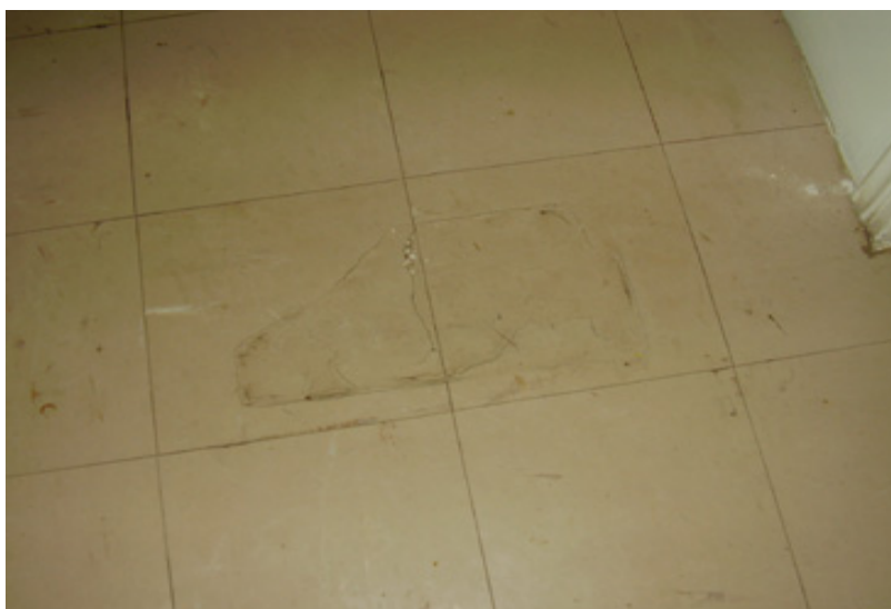
Εικόνα 5. Πλαστικά Πλακίδια από την Αίθουσα προς την πλευρά του Κτιρίου Γ.
