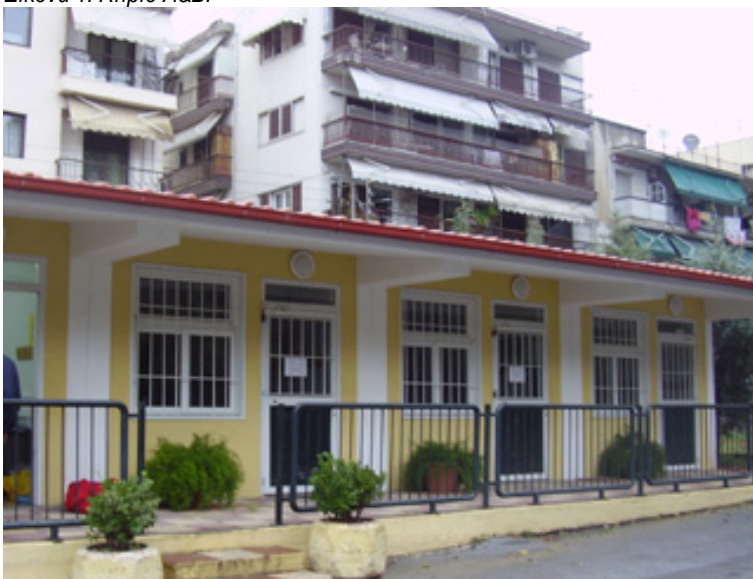
Εικόνα 2. Κτίριο Δ (ΠΡΟΚΑΤ).
