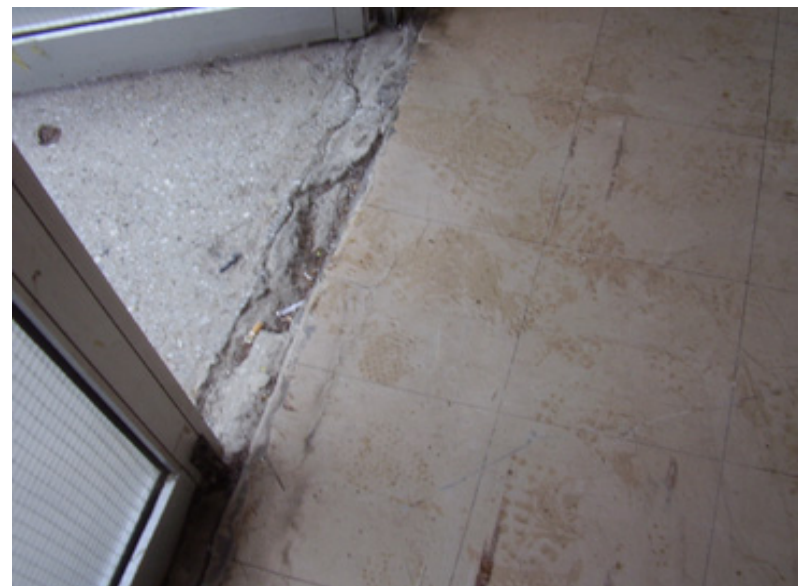
Εικόνα 7. Πλαστικά Πλακίδια Δαπέδου από τον Διάδρομο του Κτιρίου Γ.
