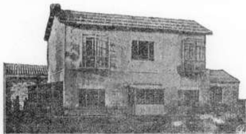
Εἰκ. 2. Σιδηροδρομικὸς σταθμὸς ἐν Ἰταλίᾳ, φέρων θύρας και παράθυρα προπεφυλαγμένα διὰ συρματίνου πλέγματος.
