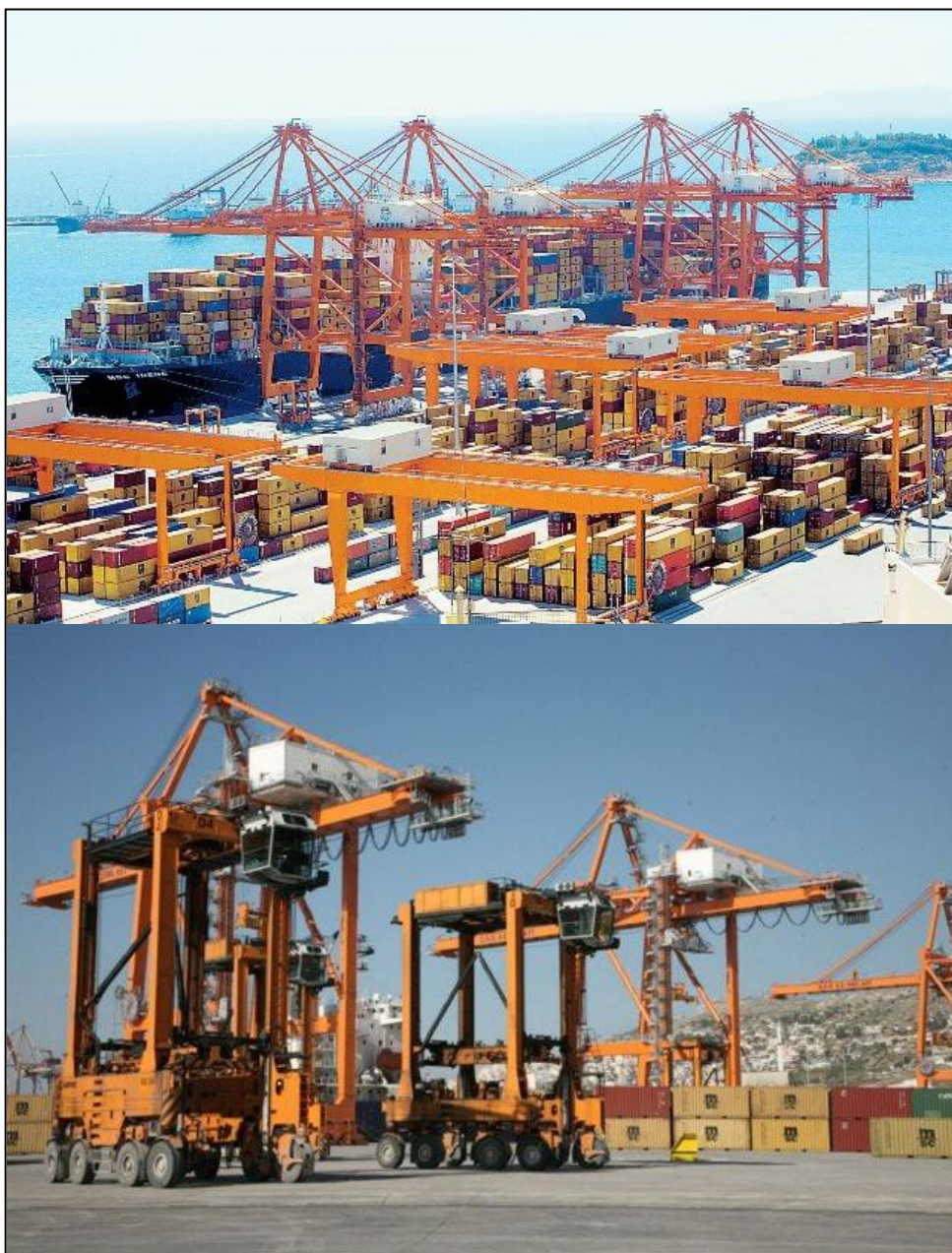
Σχήμα 25. Γερανογέφυρες και οχήματα μεταφοράς στην εμπορική αποβάθρα του ΟΛΠ.
