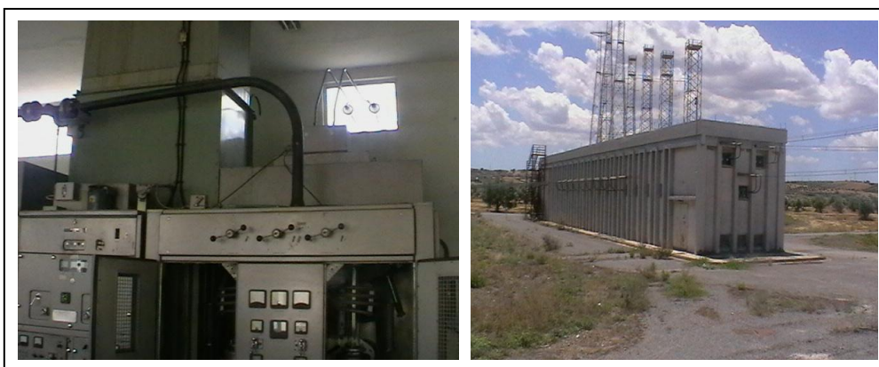
Σχήμα 23. Κέντρο εκπομπής βραχέων της ΕΡΤ στην Αυλίδα. Φαίνεται ο πομπός τύπου Marconi 11,645 MHz (αριστερά) και το matrix με τις κεραιές στο βάθος (δεξιά).
